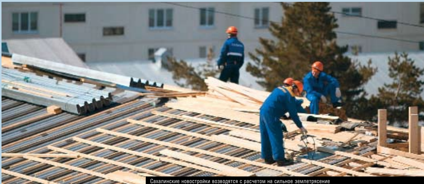
Сахалинские новостройки возводятся с расчетом на сильное землетрясение
