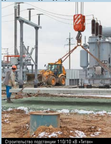
Строительство подстанции 110/10 кВ «Титан»
